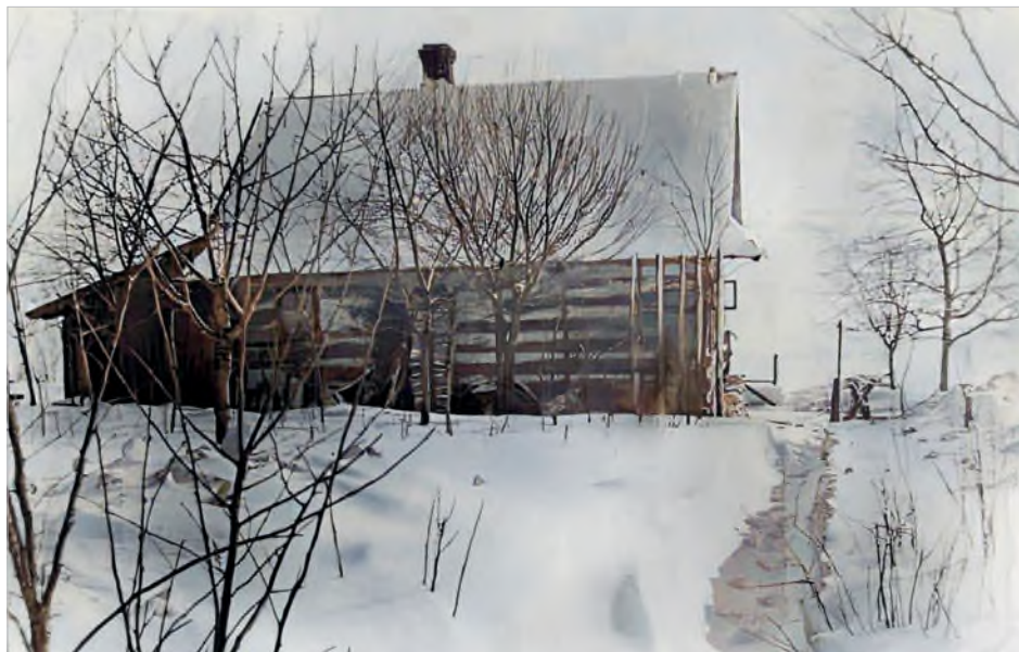
Fot. 23. Dom rodziny Ulmów wybudowany przez Józefa w latach trzydziestych XX wieku, o konstrukcji drewnianej, z dwuspadowym dachem pokrytym dachówką
