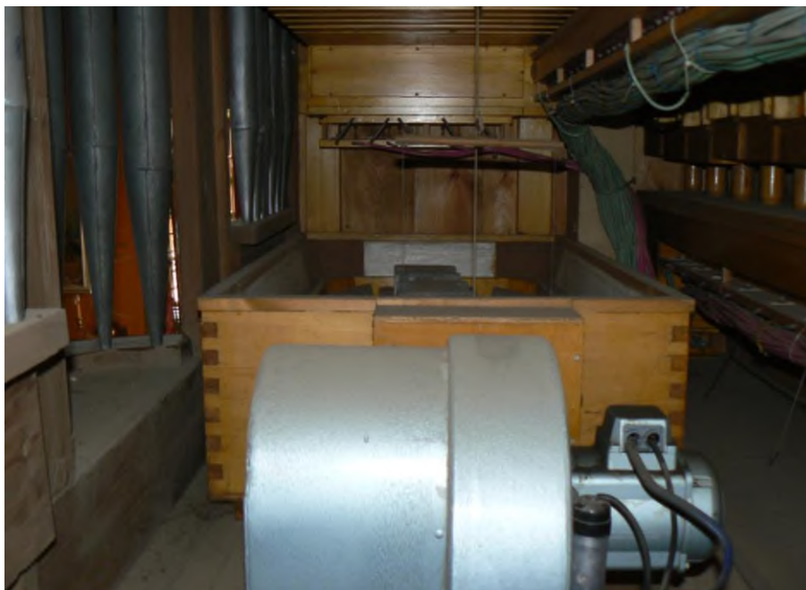
Fot. 41 Miech pływakowy wewnątrz szafy pod wiatrownicą
