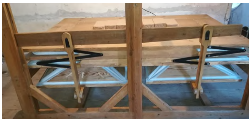
Fot. 69 Wyremontowany miecch magazynowy
