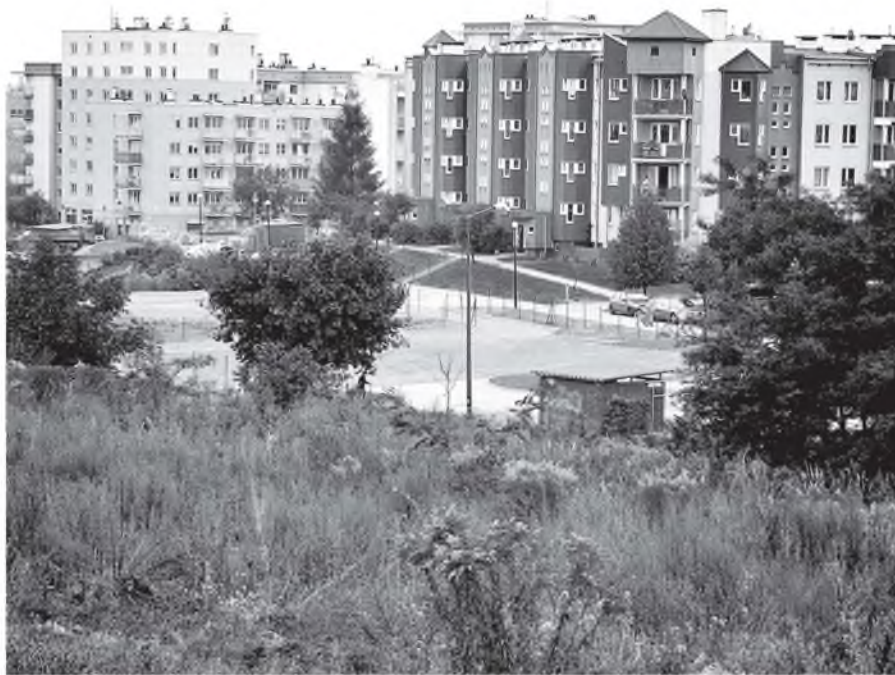
Ryc. 1. Infrastruktura techniczna na terenie suchej doliny Fig. 1. Technical infrastructure in the dry valley
