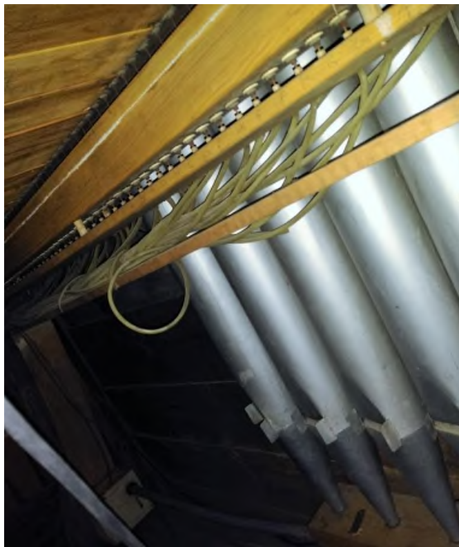
Fot. 99. Dół wiatrownicy i piszczałki organów w kościele w Kliczkowie Małym.
