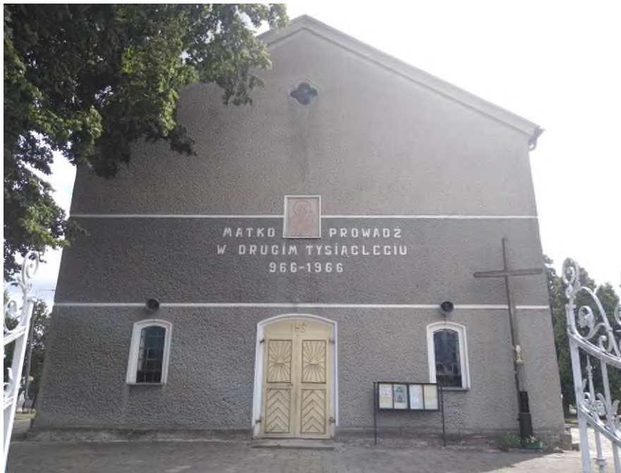
Fot. 25. Fasada kościoła w Unikowie.
