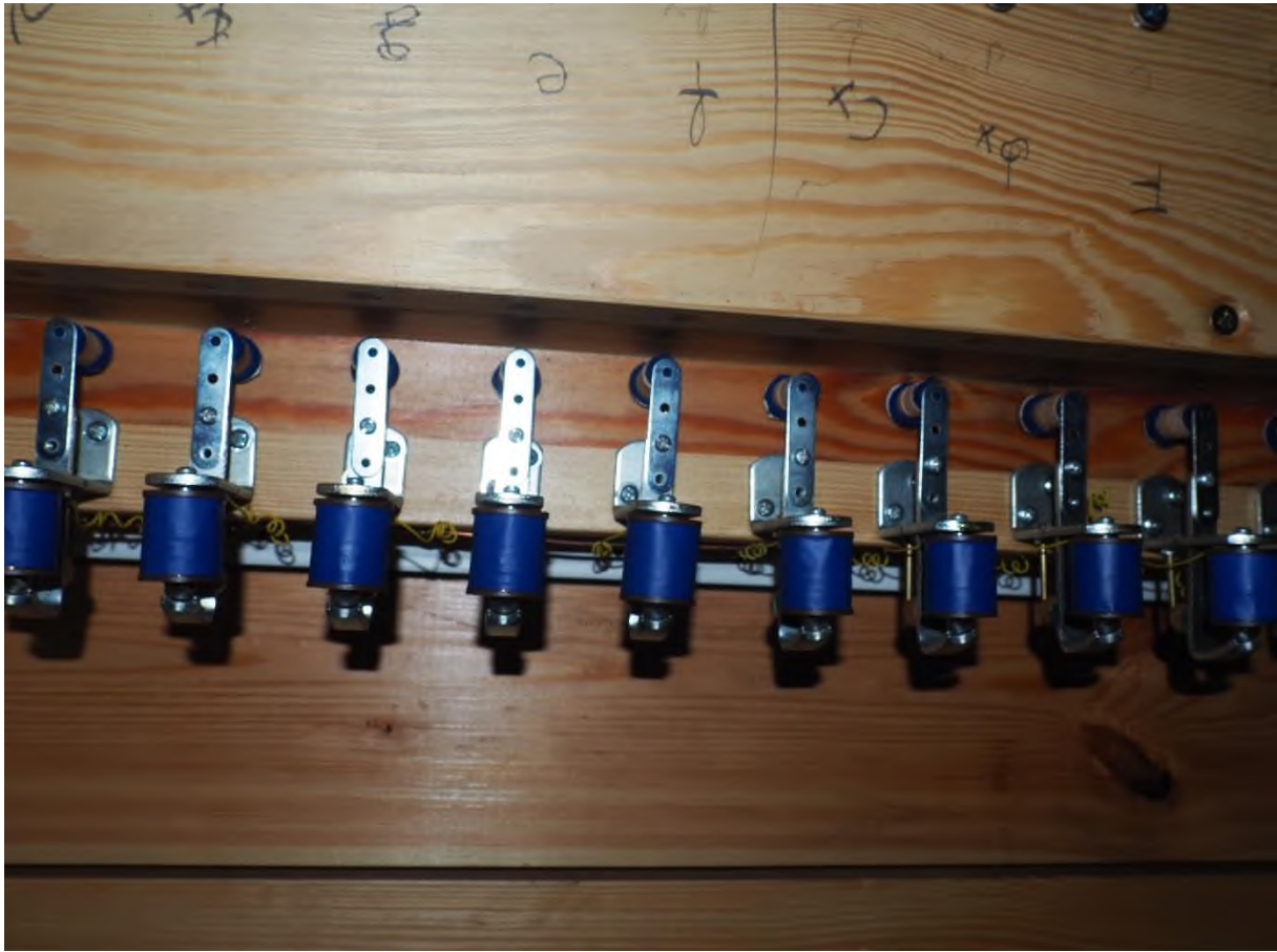
Fot. 82. Elektromagnesy w elektropneumatycznej trakturze organów w kościele par. w Brzeźniu.
