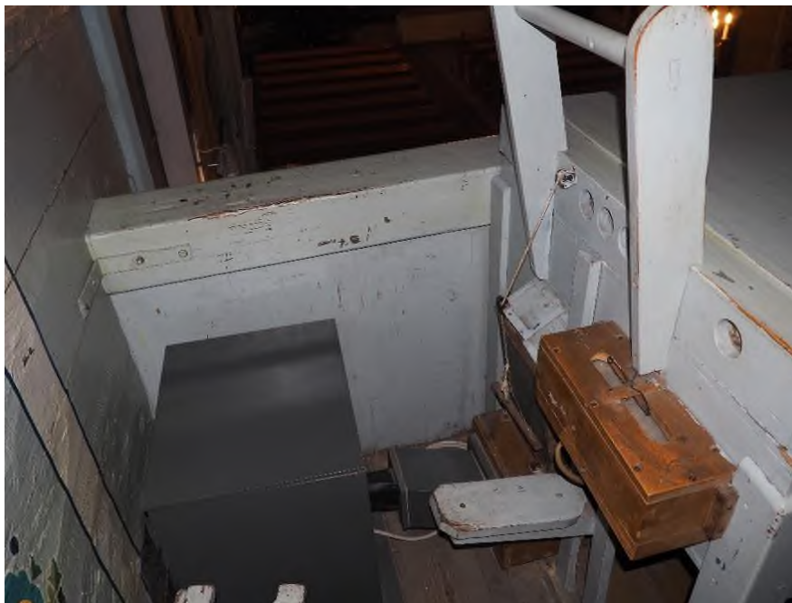
Fot. 45. Obudowa nowej dmuchawy i urządzenie do kalikowania przy miechu.
