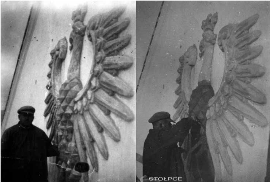
Il. 6. Dworzec na stacji Stołpce, autor – architekt Hipolit Hryncewicz przy pracach wykończeniowych godła, z kolekcji Wojciecha Odyńca
