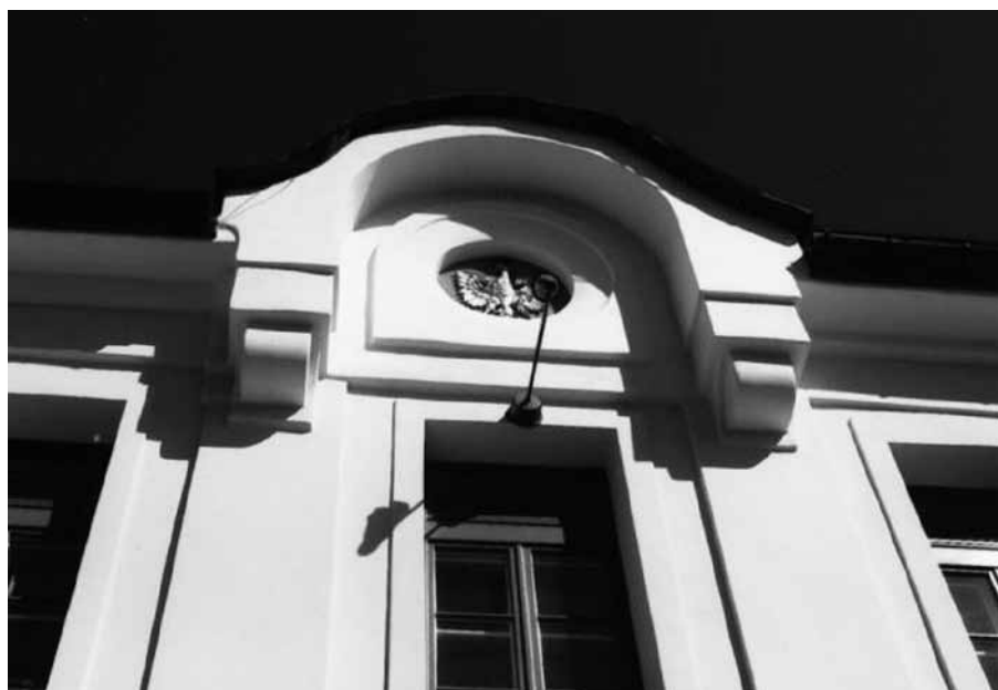
Il. 25. Radom, dworzec, szczegół elewacji południowej – godło, fot. J. Maraśkiewicz, 2014 r., ze zbiorów Wojewódzkiego Urzędu Ochrony Zabytków w Radomiu
