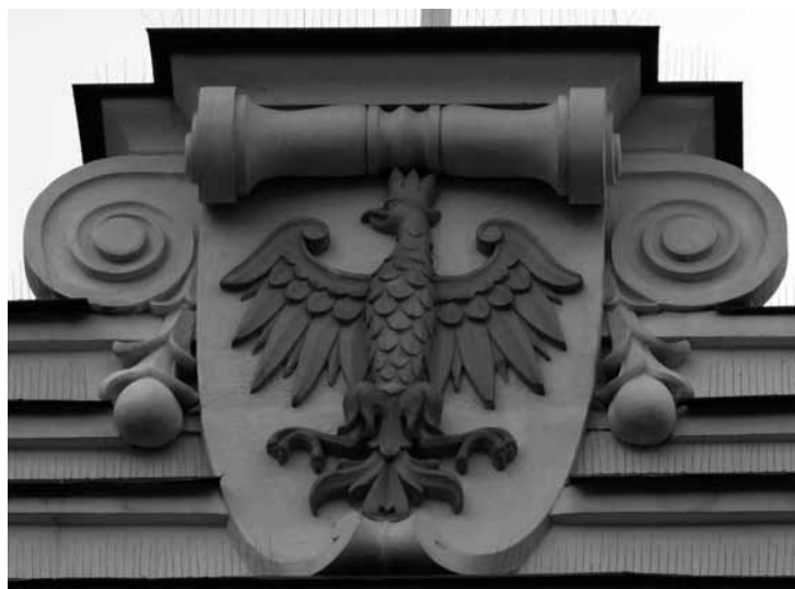
Il. 4. Lublin, Izba Skarbowa, obecnie Urząd Wojewódzki, ul. Spokojna 4, szczegól elewacji, fot. autorka 2017 r.
