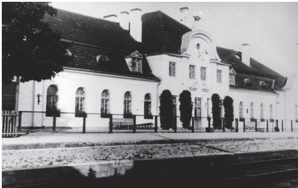
il. 6: Dworzec Hajnówka po przebudowie w dwudziestoleciu międzywojennym (zbiory Biblioteki Miejskiej w Hajnówce)
