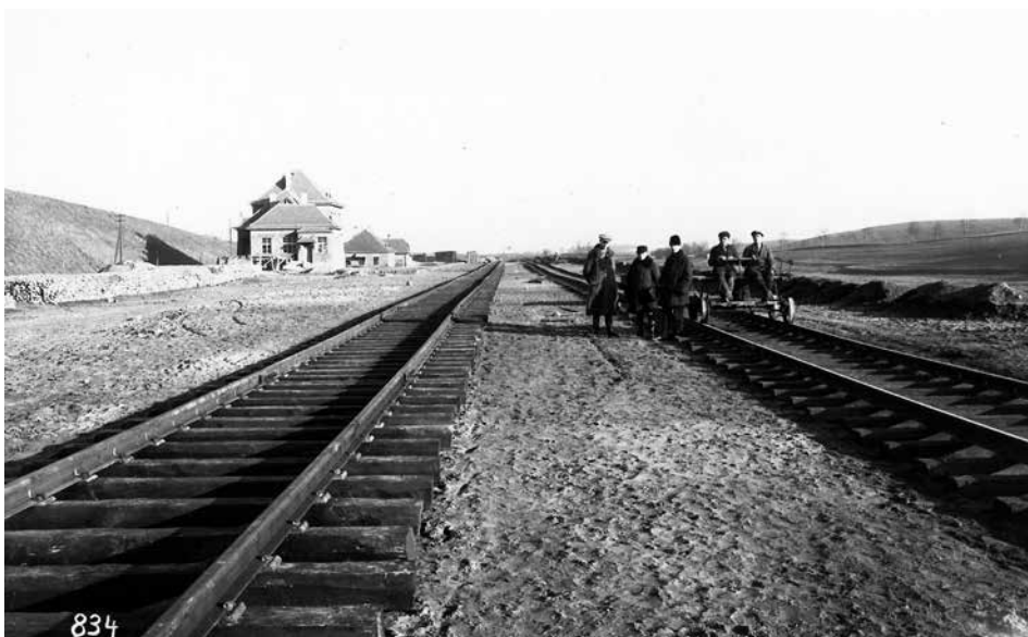
II. 16. Linia Bydgoszcz – Gdynia, odcinek Osowa – Babi Dół. Fotografia ze zbiorów Stacji Muzeum w Warszawie: album Budowa odcinka Babi Dół – Osowa linii Bydgoszcz Gdynia 1928–30 , sygn. arch 2102
