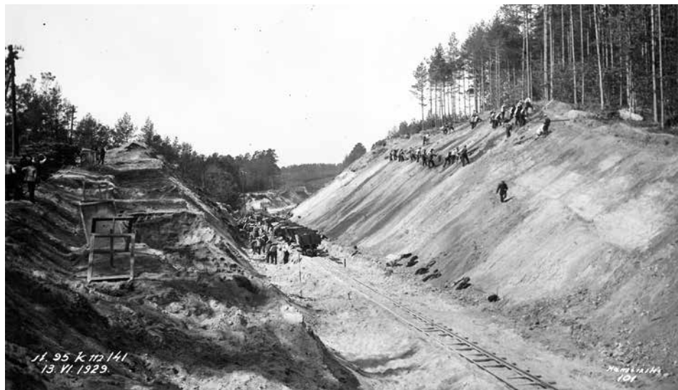
II. 26. Budowa wykopu na trasie Bydgoszcz – Gdynia. Fotografia ze zbiorów Stacji Muzeum w Warszawie: album Budowa odcinka Babi Dół – Osowa...
