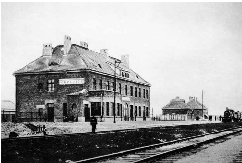
Il. 4. Dworzec na stacji Krzepice od strony torów (przed otynkowaniem). Źródło: Budowa kolei państwowej...
