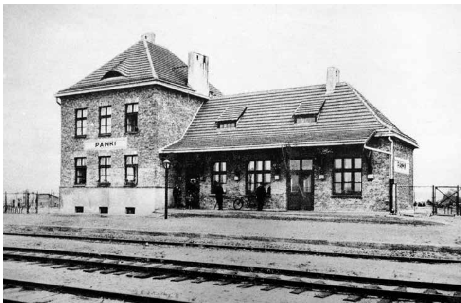
II. 6. Dworzec na stacji Panki od strony torów (przed otynkowaniem). Źródło: Budowa kolei państwowej...
