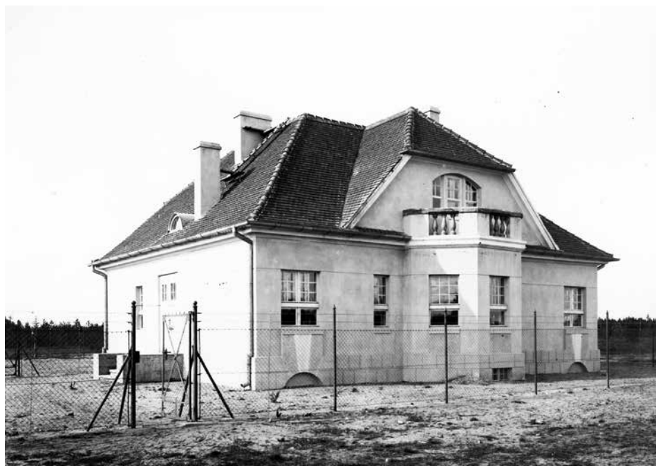
Il. 22. Dom nadzorca drogowego na stacji Bąk. Fotografia ze zbiorów Stacji Muzeum w Warszawie: album Budowa linii kolejowej Bydgoszcz – Gdynia...
