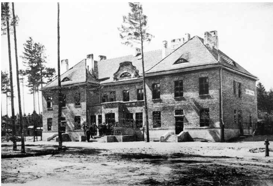
II. 3. Dworzec na stacji Herby Nowe od strony dziedzica (przed otynkowaniem). Źródło: Budowa kolei państwowej...
