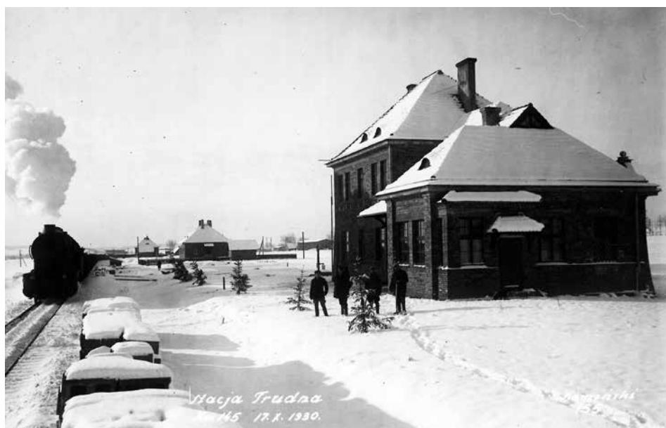
II. 18. Dworzec na stacji Trudna (przed otynkowaniem). Fotografia ze zbiorów Stacji Muzeum w Warszawie: album Budowa odcinka Babi Dół – Osowa...
