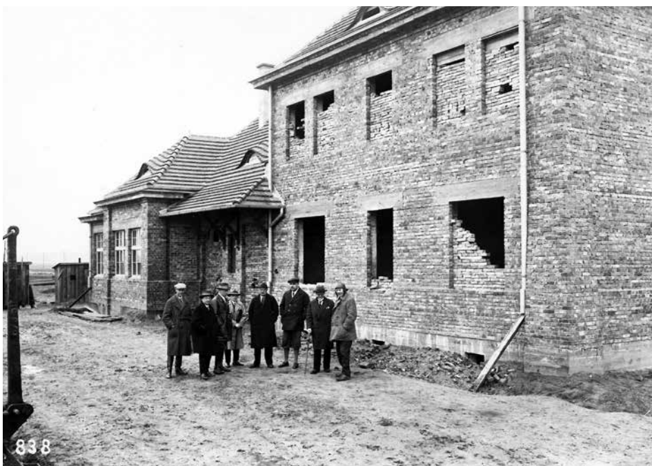
II. 17. Dworzec typu dworca Bydgoszcz – Gdynia (w trakcie budowy). Fotografia ze zbiorów Stacji Muzeum w Warszawie: album Budowa odcinka Babi Dół – Osowa...
