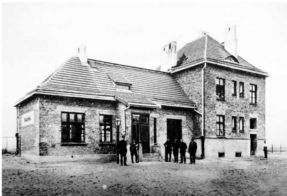
II. 7. Dworzec na stacji Panki od strony dziedzińca (przed otynkowaniem). Źródło: Budowa kolei państwowej...
