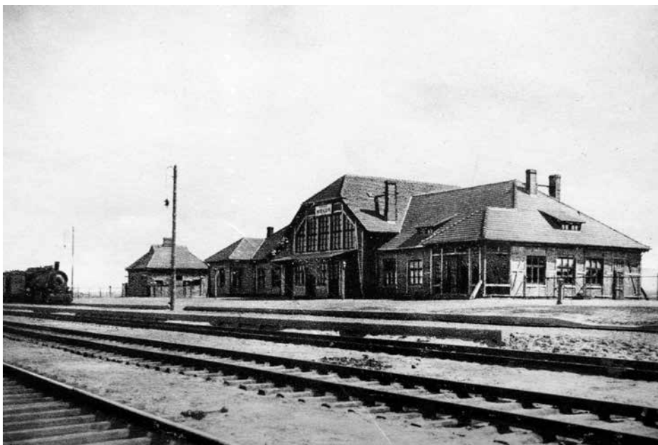
II. 9. Dworzec na stacji Wieluń od strony torów. Źródło: Budowa kolei państwowej...
