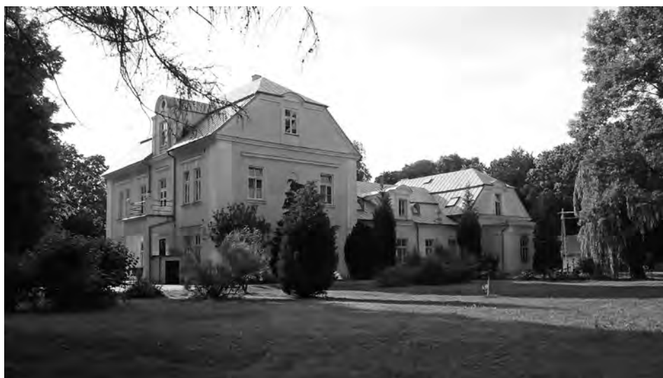
Pałac Woronieckich w Kaniach – widok na wejście główne
