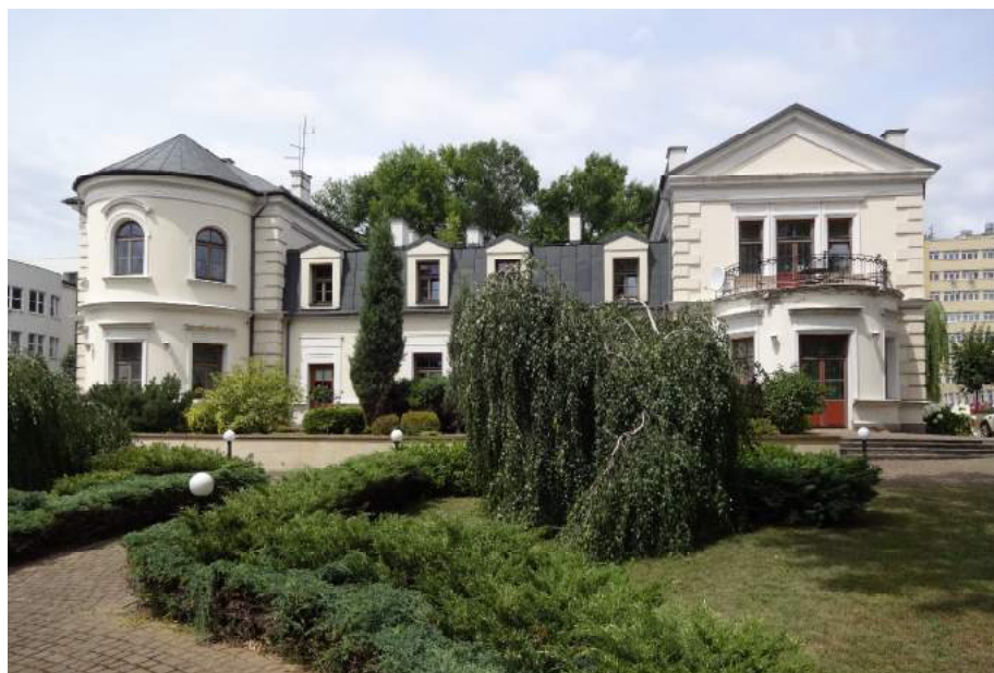
Il. 5. Dwór pojezuicki – Rektorat Politechniki Lubelskiej, elewacja ogrodowa, fot. A. Tejszerska, 2016
