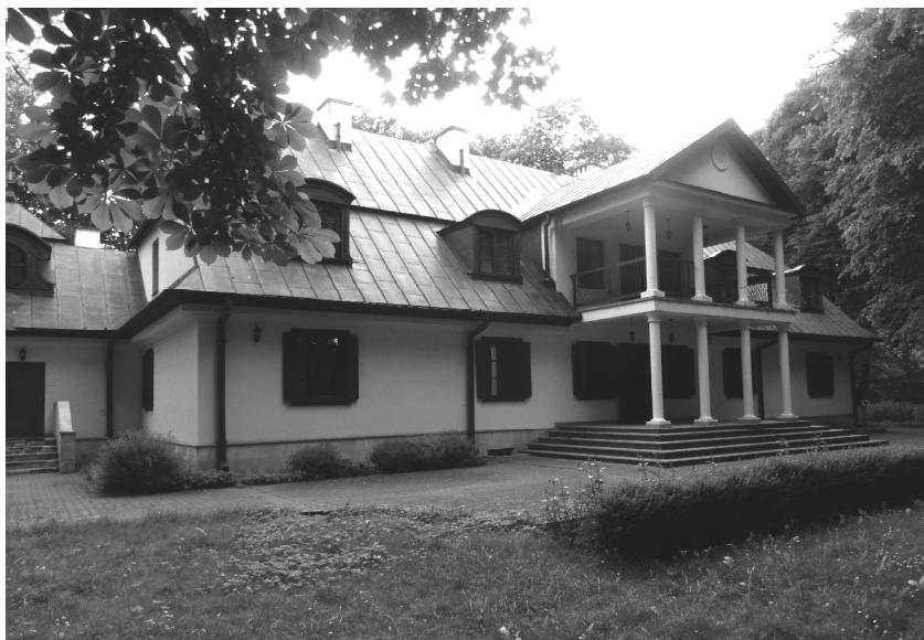
Il. 9. Dworek na Konstantynowie, elewacja wschodnia, fot. A. Tejszerska, 2016
