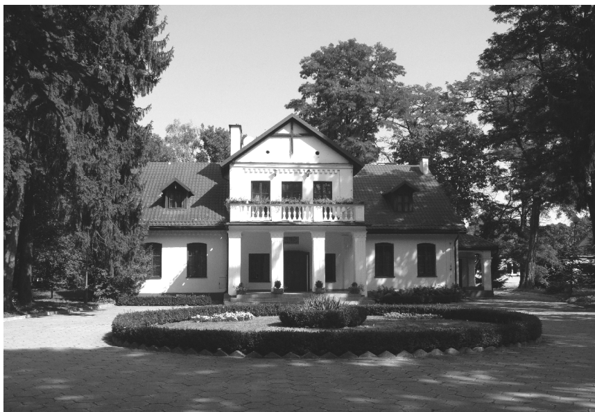
Il. 3. Dwór na Felinie, elewacja frontowa, fot. A. Tejszerska, 2016
