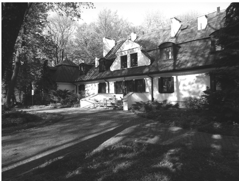
Il. 10. Dworek na Konstantynowie, elewacja zachodnia, fot. A. Tejszerska, 2016
