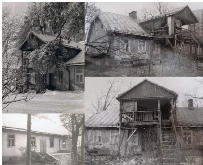
Il. 8. Dworek na Konstantynowie, kolumna lewa – lata 60., kolumna prawa – lata 90. – przed rozbiórką, fot. z kronik Zgromadzenia sióstr urszulanek
