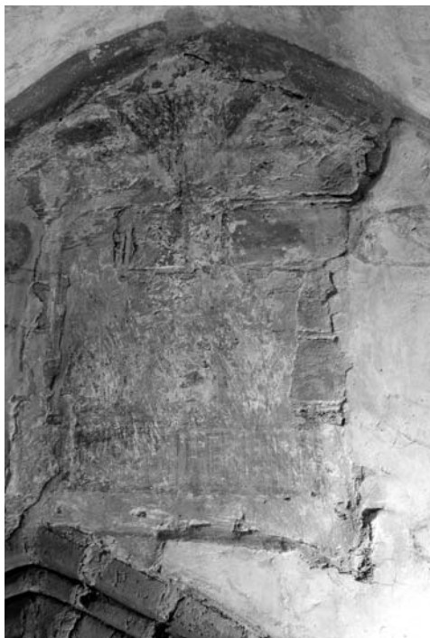
Il.3. Środkowa część malowidła na ścianie wschodniej prezbiterium kościoła św. Jakuba w Toruniu w 2014 roku, po oczyszczeniu powierzchni. (fot. Rafał Jaguś)
